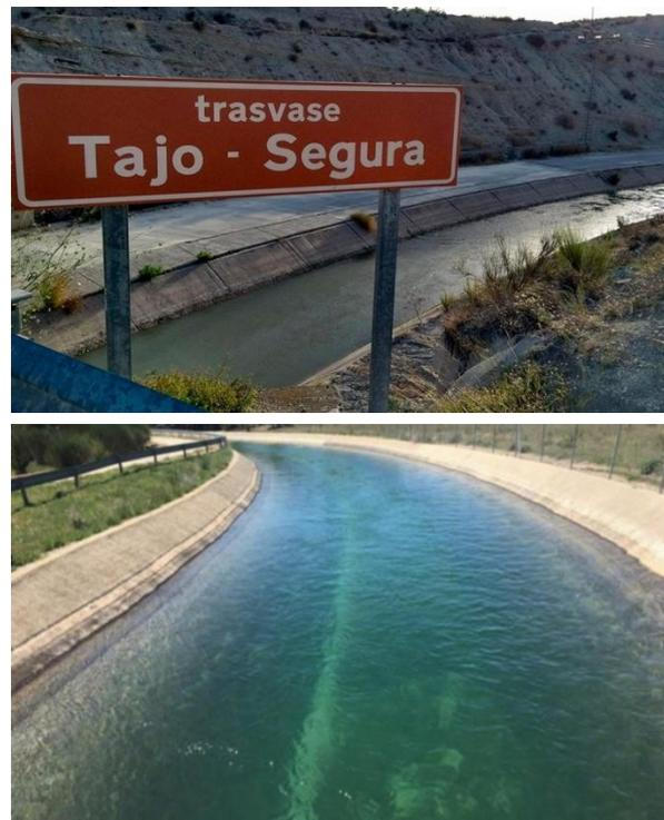
El trasvase Tajo-Segura conecta el embalse de Bolarque, en el río Tajo con el embalse de Talave, en el río Mundo, afluente del río Segura. Tiene una longitud de 292 km y capacidad para un caudal de 33 m<sup>3</sup>/s.
